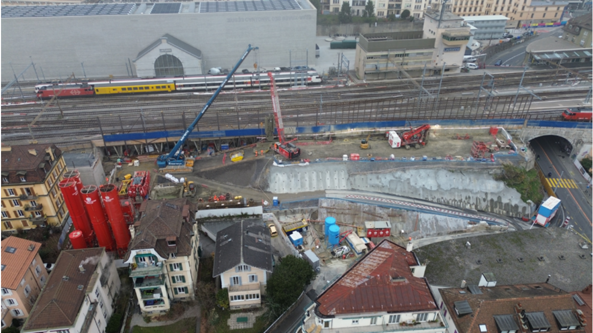
Vue globale du chantier pour la construction du bâtiment des Epinettes.
