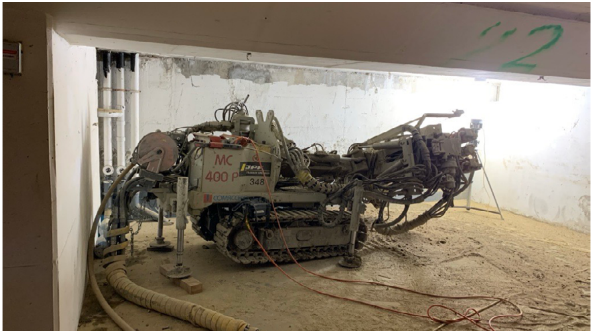
La machine qui réalise les ancrages dans l'ancien parking souterrain à la rue du Simplon.
