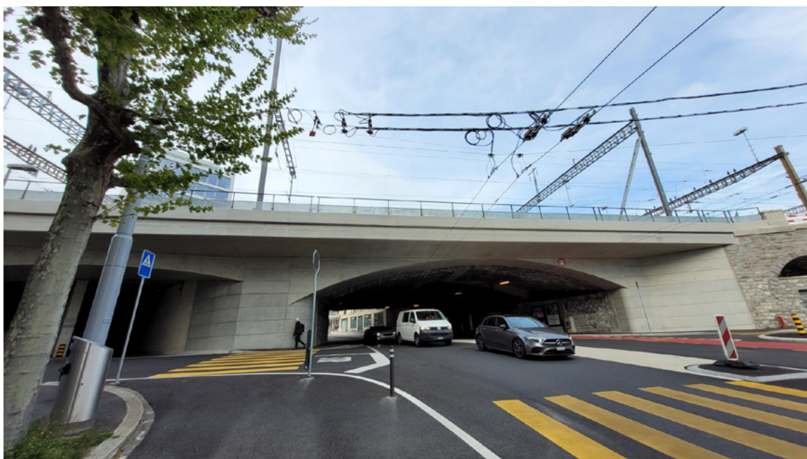
Le pont sur l'avenue d'Ouchy complètement terminé.
