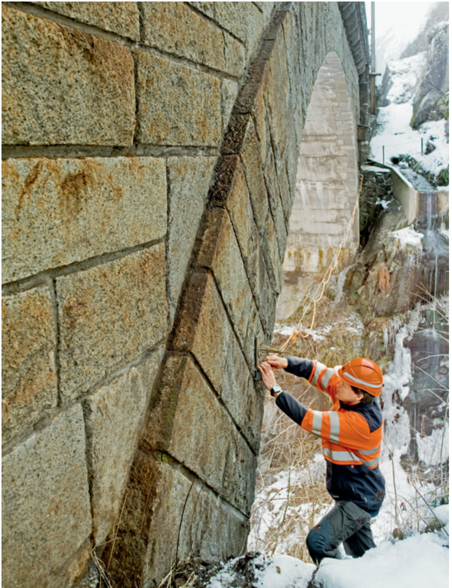
20 Inspektoren prüfen alle sechs Jahre sämtliche 6100 SBB-Brücken auf Herz und Nieren, jeden Tag etwa sechs. Hier die Häggrigerbachbrücke am Gotthard.
