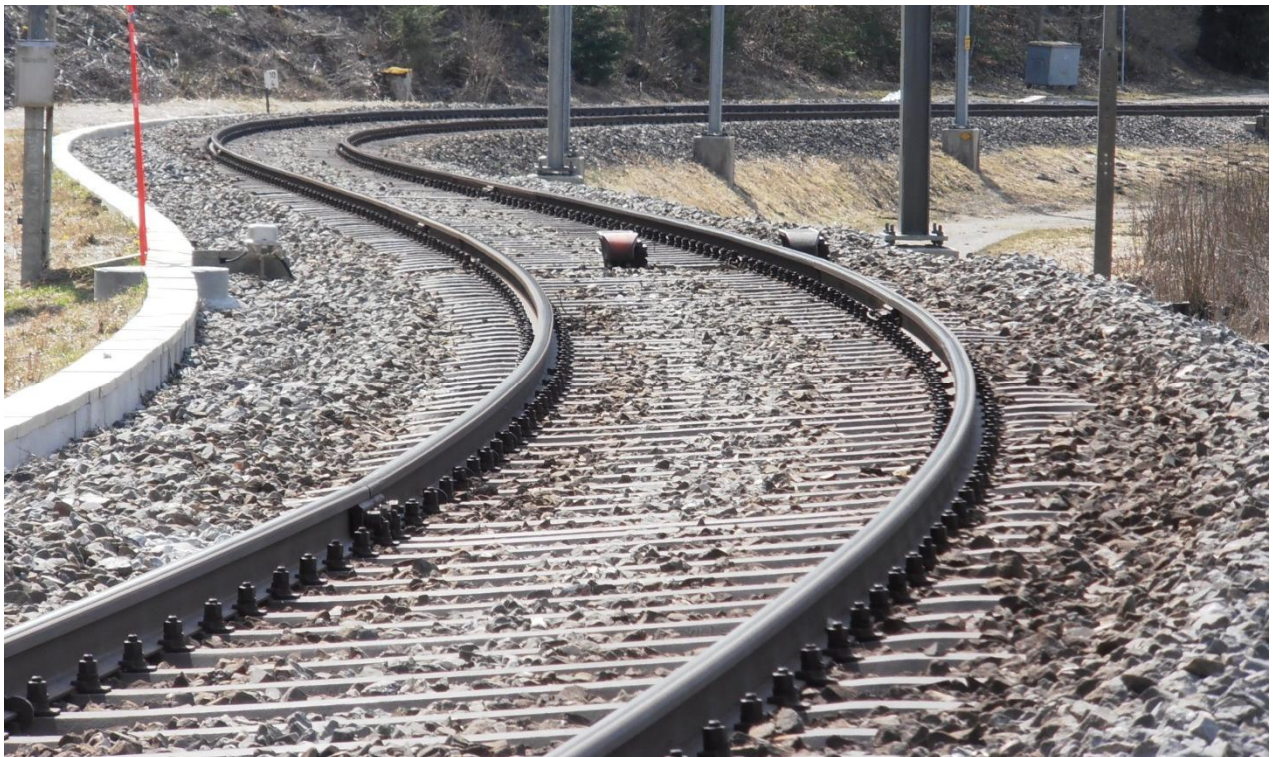
Abb. 1-1: Typische Trassierung mit fahrtechnisch anspruchsvollen Gleisbögen mit R < 250 m (Quelle: SBB I-AT-FW-TNZ)
