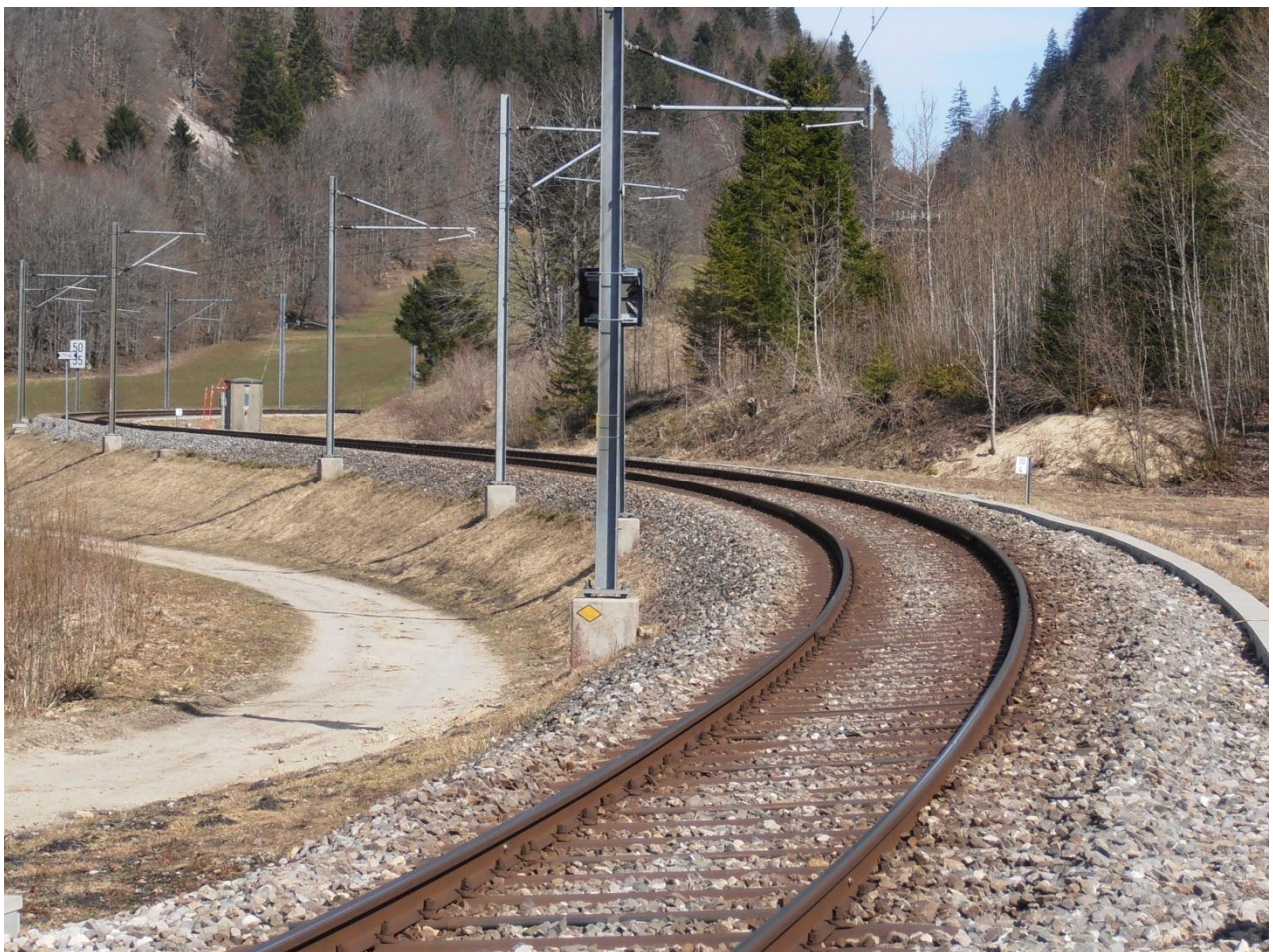
Abbildung (Abb.) 1: 200 m-Gleisbogen mit nachfolgendem 178 m-Gegenbogen (Quelle: SBB I-AT-FW-TNZ)
