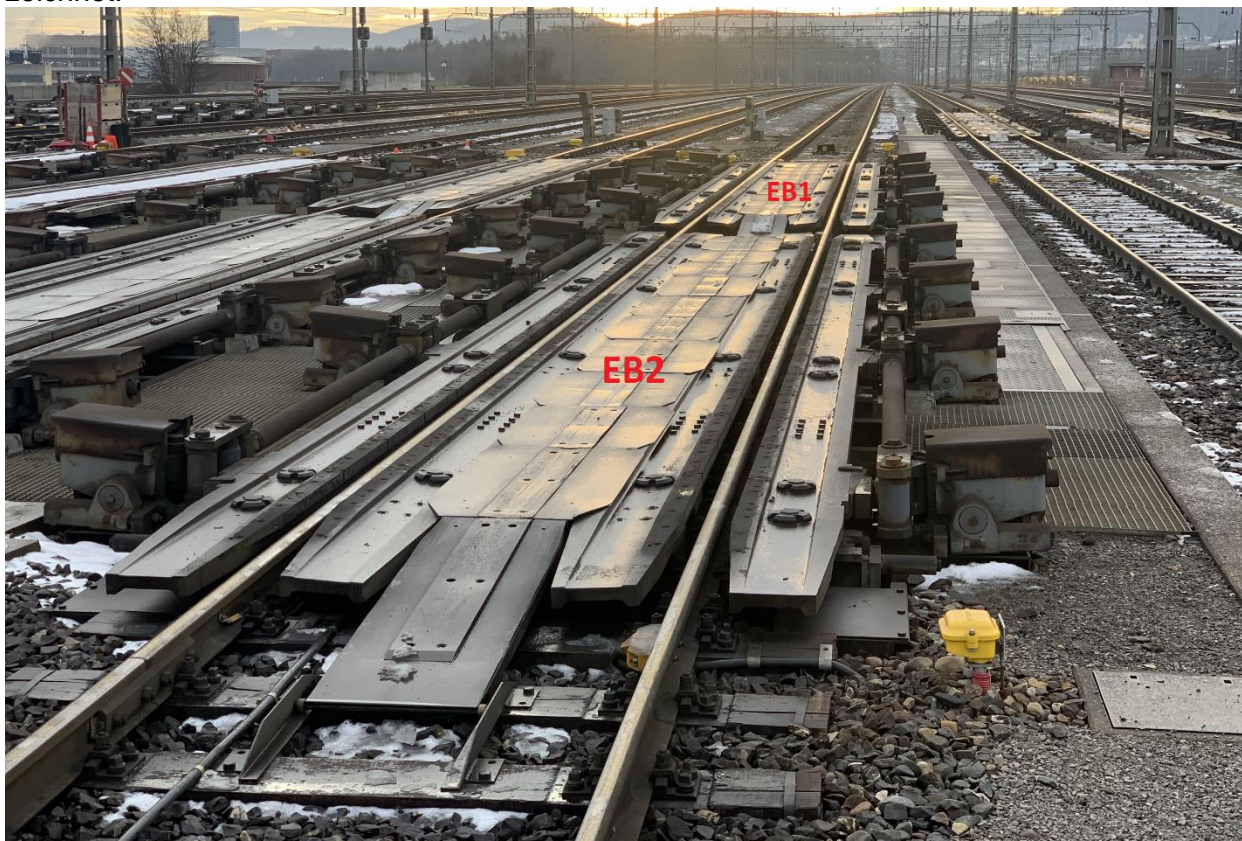
Abbildung 1 Zweiteilige Einlaufbremse E-Gruppe
