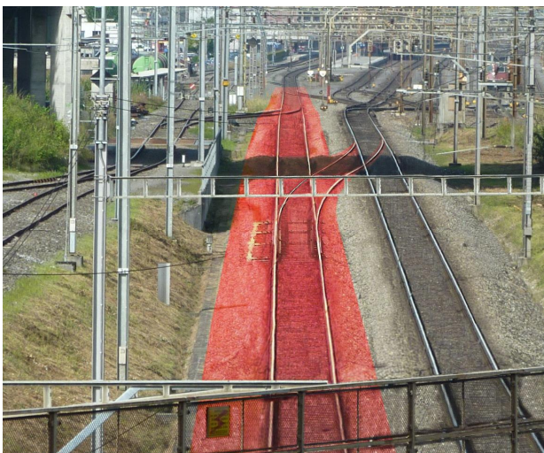
Visualisierung des 2. Gleises (rot) mit Blick in Richtung Bahnhof Rotkreuz (Fahrtrichtung Luzern).
