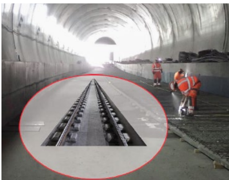
Vorbereitung der Betonplatte für die feste Fahrbahn.
