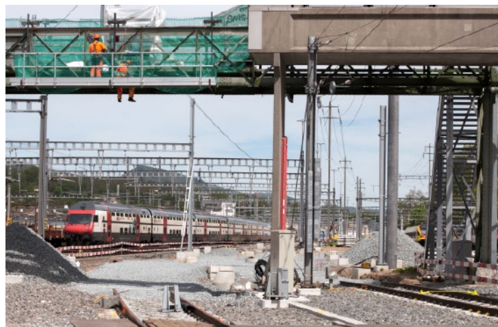
Passerelle in Olten und Vorschotterung für den Weicheneinbau im Mai 2019.
