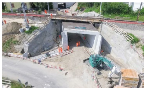
Stand Juni 2018 nach dem Einschub der vorgefertigten Unterführung.
