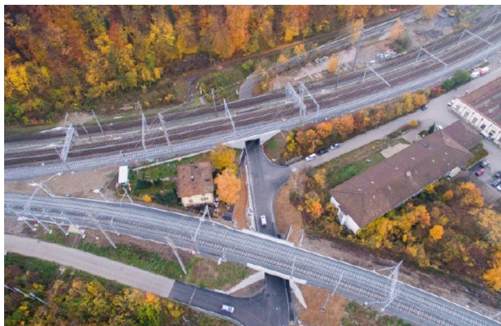
Stand Ende 2018 nach dem Einbau der Bahntechnik.
