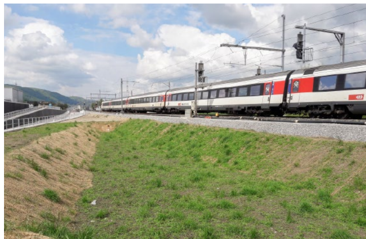
Versickerungsbecken Gretzenbach und Güterstrasse Süd.
