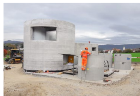
Kopfgebäude des Notausstiegs in Gretzenbach.
