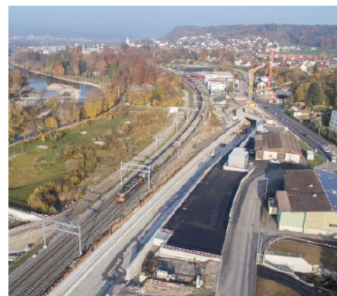
Drohnenaufnahme vom Rampenbauwerk in Gretzenbach mit Blick in Richtung Eppenbergtunnel.
