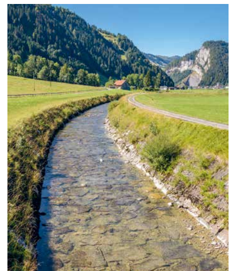
Minster heute: Ungenügender Hochwasserschutz.
