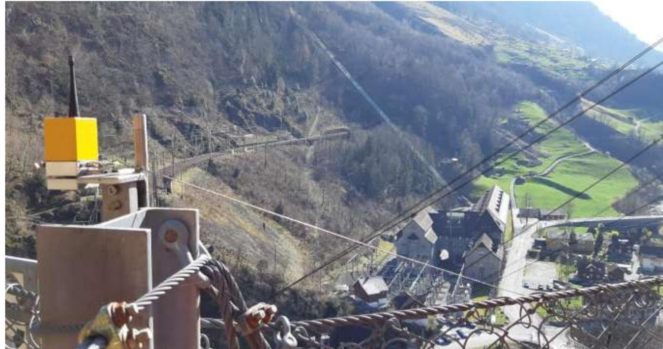
Die Anlagen erkennen Steinschlag, Felssturz, Hangrutsch, Murgang, Lawine und Schneerutsch im Gelände oder Schutzverbauungen. Alarmierung über ZKE – rechtzeitiges Stoppen von Zügen verhindert schwere Unfälle durch Kollisionen mit Fels- oder Erdmaterial und Entgleisungen.
