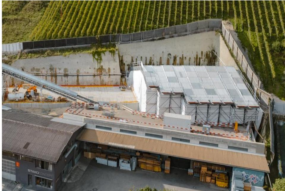
Einbau eines lärm- und staubdichten Daches für die Dauer des Tunnelvortriebs (kann geöffnet werden, um Material zu bringen).
