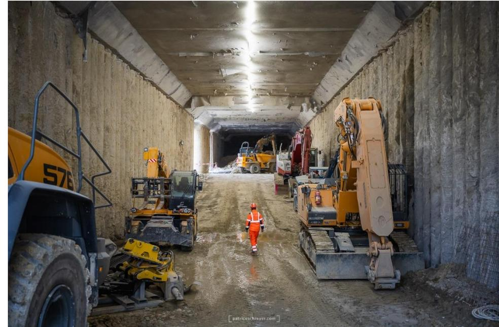
Unterirdische Baustelle, Keine grosse Belästigung durch Maschinen, die durch den gedeckten Graben zufahren.
