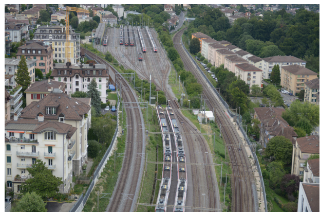
Faisceau de voies de garage des Paleyres avant travaux.
