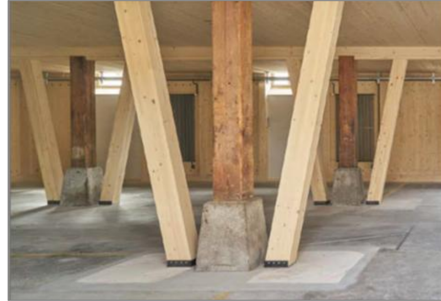
Baubüro in situ fondation de colonne (Zürich, 2022)
