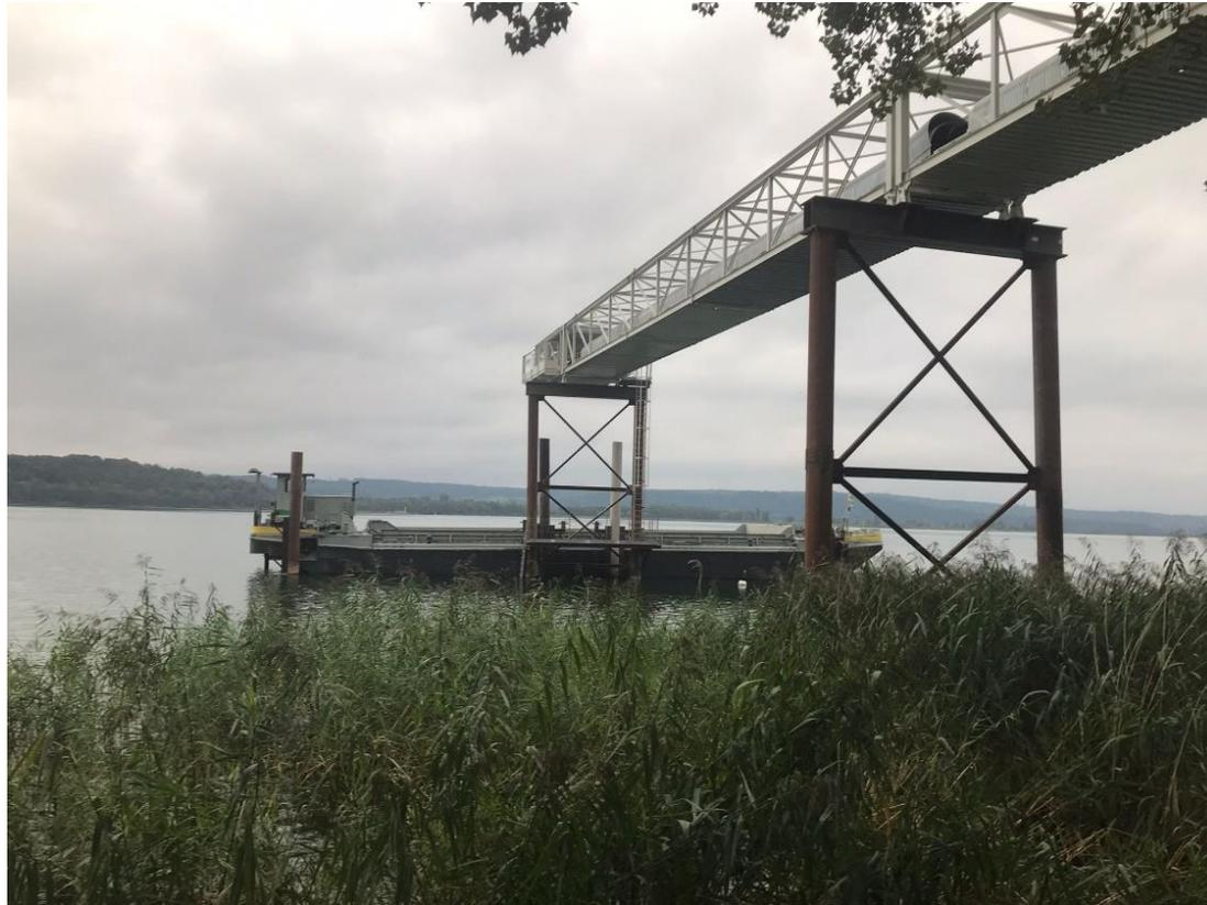
Les matériaux du tunnel sont évacués par barges via le convoyeur (sauf cas de force majeure : forte bise, panne du convoyeur, ... ).
