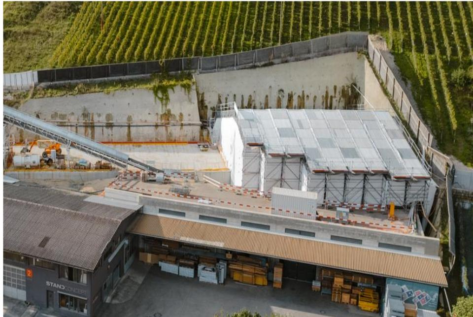
Pose d'une toiture anti-bruit et anti-poussière pour la durée de la creuse du tunnel (peut être ouvert pour amener des matériaux).
