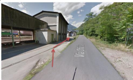
Einfahrt zur HUPAC-Halle
