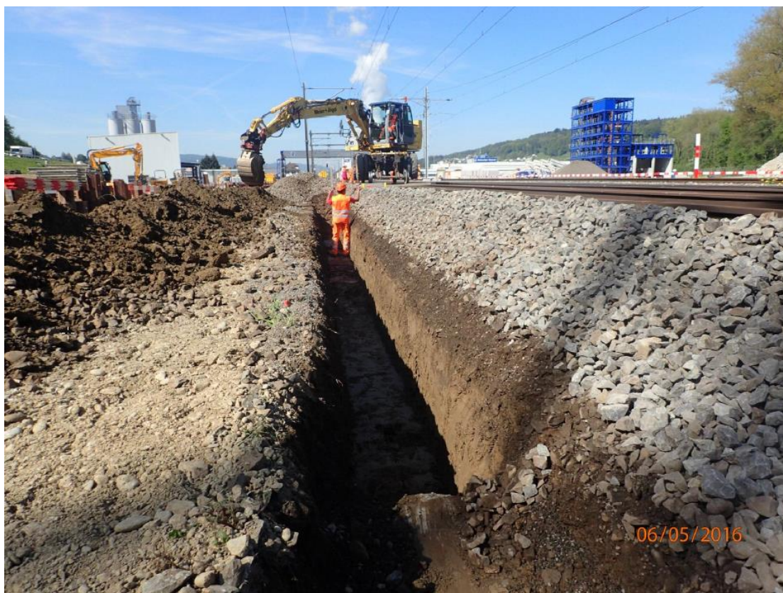
Schotterflanke instabilisiert
