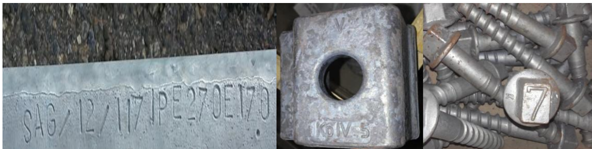
Abbildung 2: Beispiele für Bauteilkennzeichnungen
