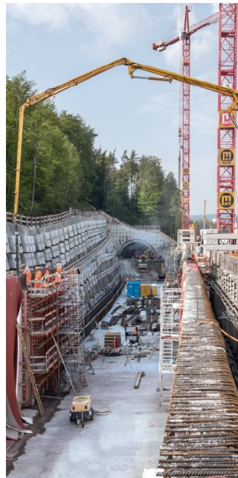
Baugrube Portal Eppenbergtunnel in Wöschnau.
