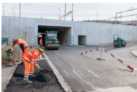
Verlängerte Unterführung beim Postzentrum mit den anschliessenden Stützmauern.
