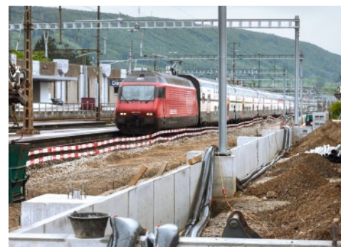
Bau des neuen Perrons am Bahnhof Däniken.
