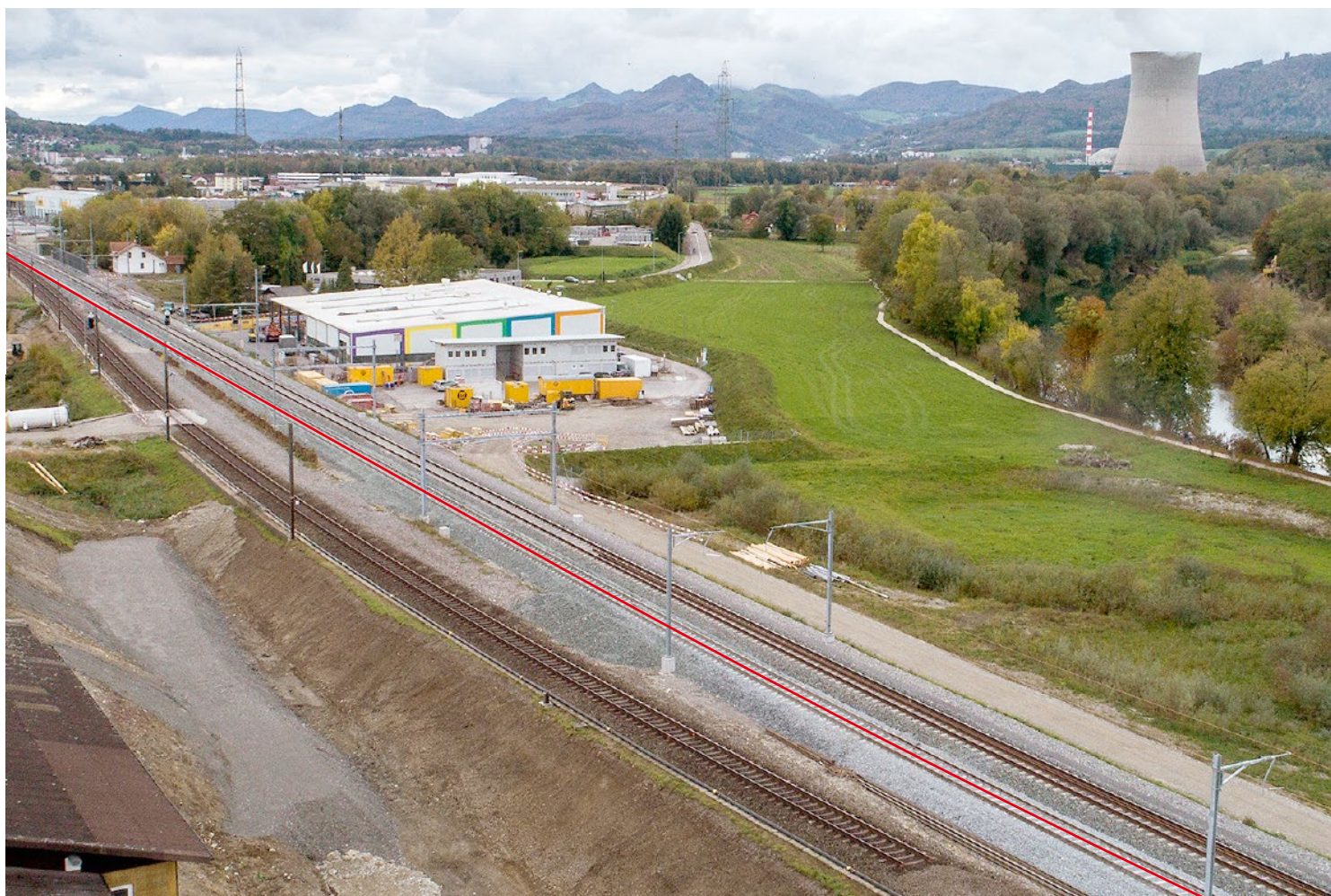
9. Oktober 2017: Neues Gleis an die Stammlinie angeschlossen, das Gleis links im Bild wird zurückgebaut, damit die zweispurige Zufahrt zum Eppenbergtunnel gebaut werden kann.
