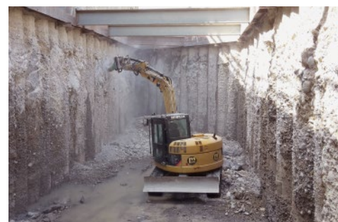
Die Grube ohne Wasser macht die Betonarbeiten des Tauchers sichtbar.
