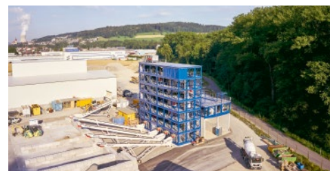
Materialaufbereitungsanlage sortiert Tunnelausbruchmaterial vor Ort.
