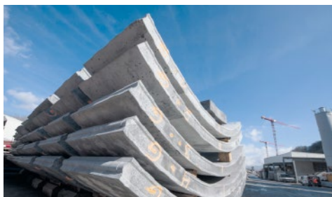
Tübbing-Lager auf der Eppenberger Baustelle.
