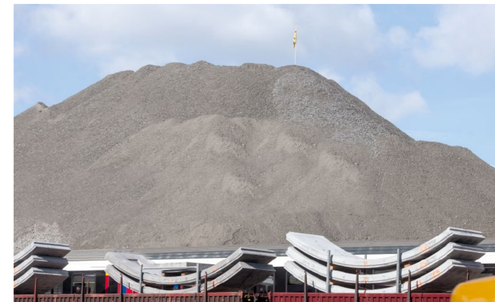
Zwischenlager des Tunnelausbruchmaterials mit Tübbing-Zug im Vordergrund.
