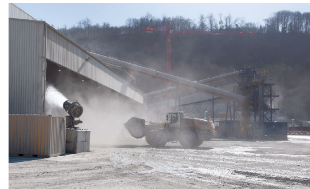
Abwurfhalle mit Ausbruchmaterial. Links im Bild ist eine der drei Schneekanonen zu sehen.
